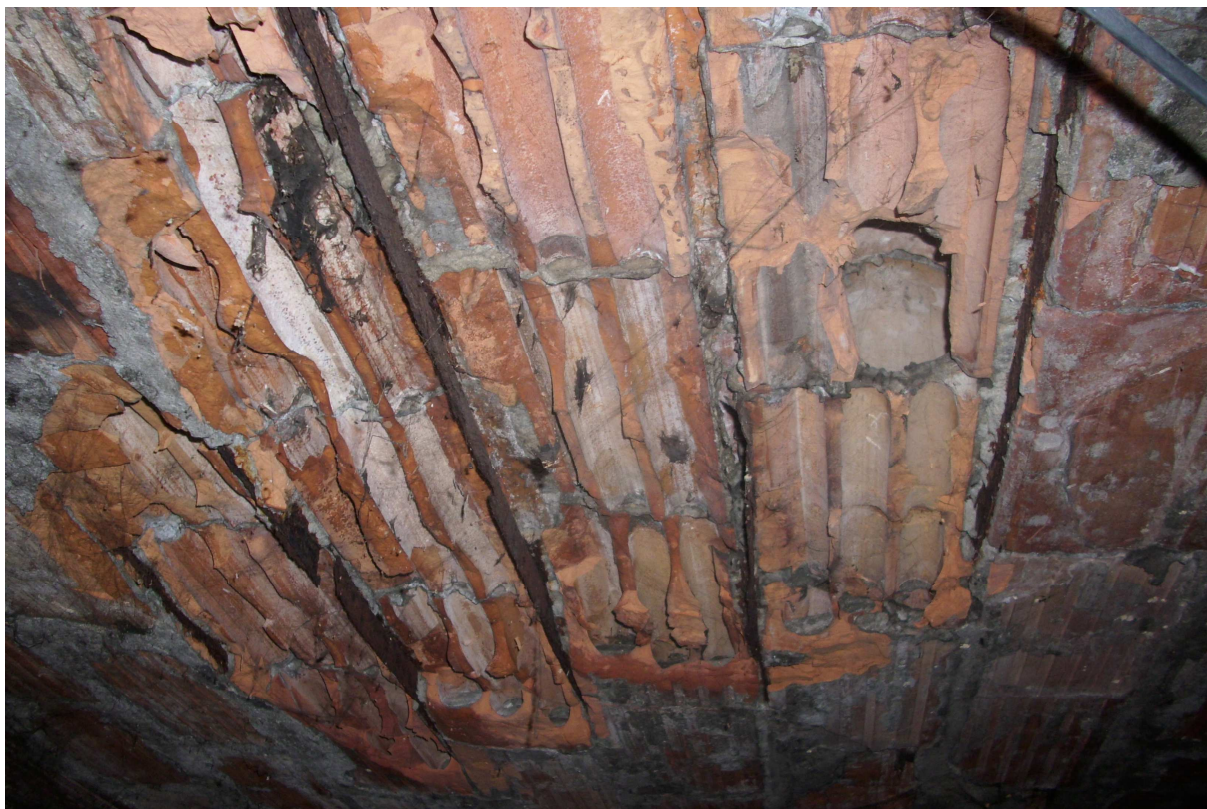
Zdjęcie nr 3 – uszkodzony fragment stropu pod kuchnią
