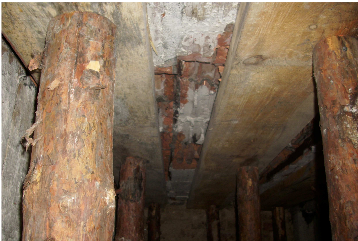
Zdjęcie nr 2 – podstemplowany, uszkodzony strop pod łazienką
