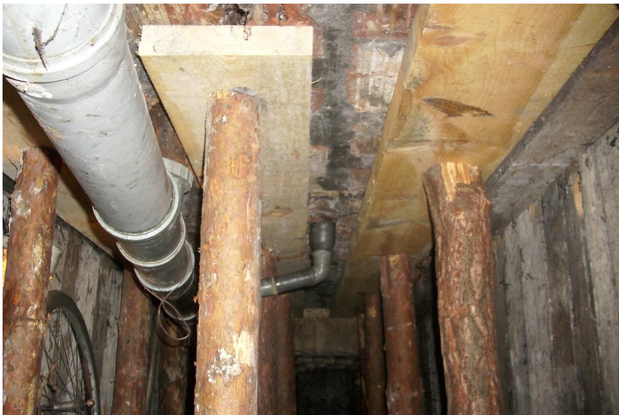
Zdjęcie nr 1 – podstemplowany, uszkodzony strop pod łazienką
