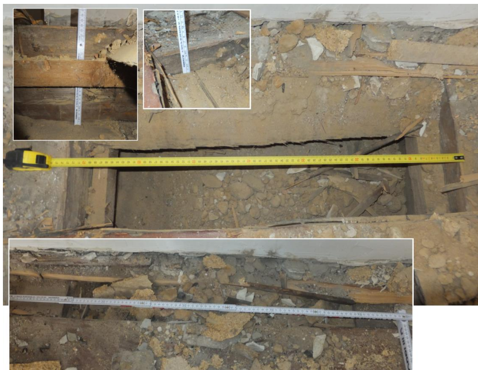
Fot. Odkrywki - Belki konstrukcyjne stropu drewnianego
