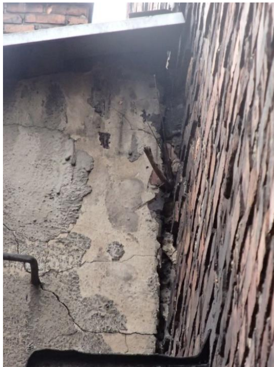
4. Widok na dylatację głównej konstrukcji z budynkiem 1 Maja 26a.
